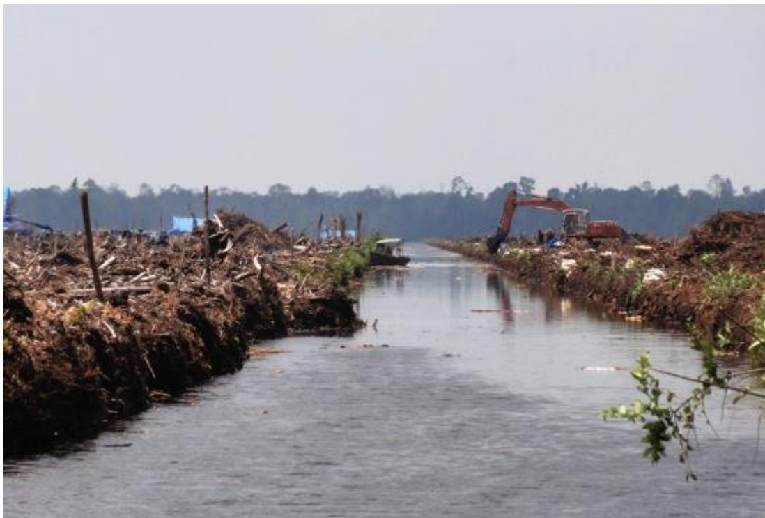
Foto 4. Hamparan areal penebangan hutan alam oleh ekspansi HTI PT. Triomas FDI. Foto ini juga memperlihatkan galian kanal di permukaan kawasan gambut, juga terlihat satu unit alat berat yang lagi melakukan penggalian kanal yang bisa berdampak bagi pemanasan global akibat terlepasnya emisi karbon. Foto pada titik koordinat N0°34'51.25" E102°55'30.87" . Foto EoF, 21 September 2013
